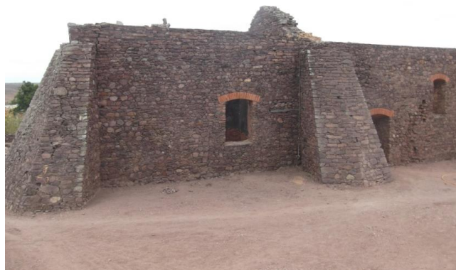
Figura 16 - Dois contrafortes existentes na fachada lateral esquerda [12].
