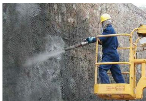
Figura 37 - Aplicação de reboco armado com betão projetado em parede de alvenaria [46].
