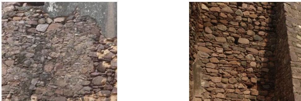
Figura 24 - Parede de alvenaria de pedra ordinária argamassada (esquerda). Parede de alvenaria de pedra seca (direita). Ambas as imagens dizem respeito às paredes da Igreja de N. Sr. a do Rosário.
