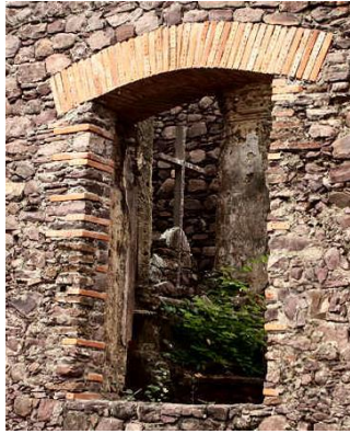
Figura 25 - Arco de descarga de uma das janelas da Igreja [31].
