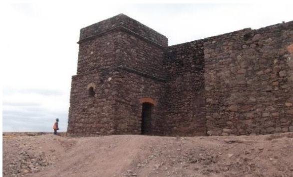
Figura 21 - Tardoz da torre de campanário e fachada lateral direita da igreja [12].
