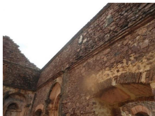
Parede interior da sala da ante-câmara.
