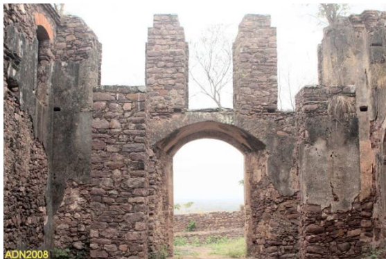
Figura 12 - Ruínas do interior da Igreja de Nossa Senhora do Rosário (2008). Fotografia de A. Dimas Neto [31].
