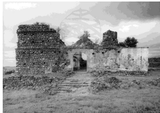
Figura 13 - Ruínas do exterior da Igreja de Nossa Senhora do Rosário (1965) [45].
